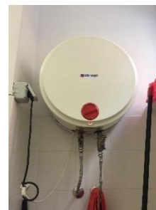
Figura 4.13 - Particolare di un boiler elettrico per la produzione di acqua calda sanitaria
