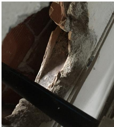
Figura 4.1 - Particolare della porzione di involucro
