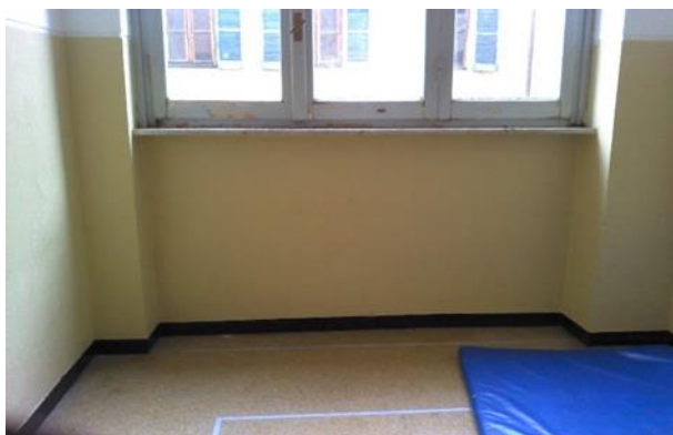
Figura 4.3 – Rilievo termografico della parete
