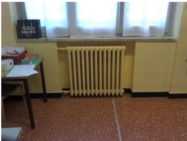
Figura 4.7 – Rilievo termografico dei radiatori
