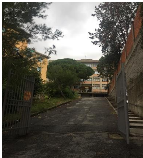
Figura 1.1 - Vista della facciata esposta a Sud
